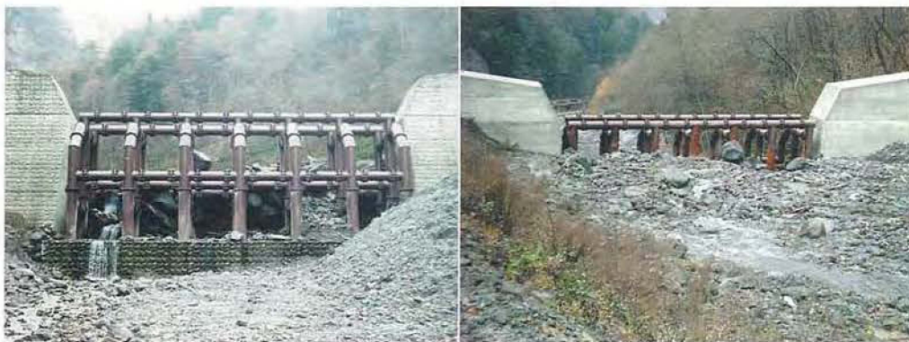
図3 土石流の捕捉事例
