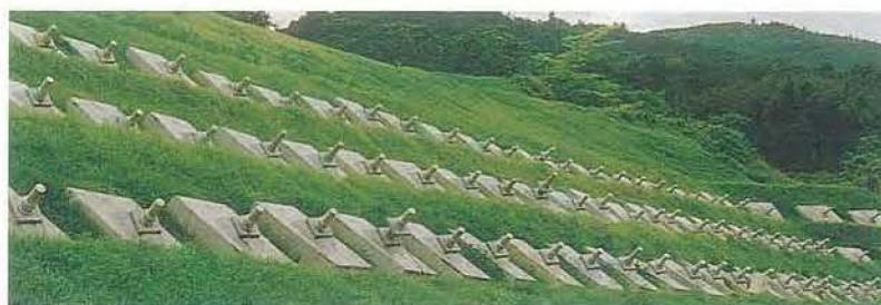
写真3 SEEE永久グラウンドアンカー工法(タイプルアンカーA型)現場施工例
