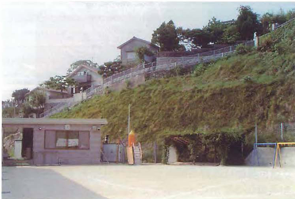
写真2 施工2年後の状況
