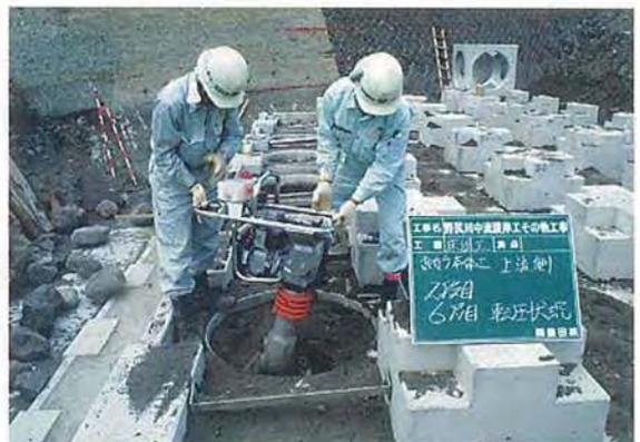
写真11 中詰材 (現地発生土砂) 投入、締固め工
