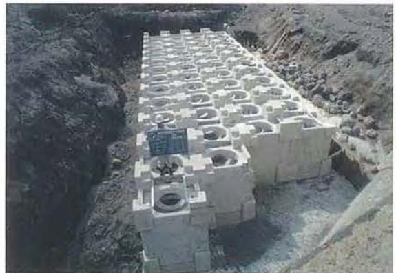
写真10 中空ブロック、十字ブロック設置工
