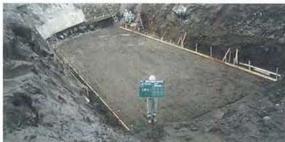
写真9 床掘・基面整正工
