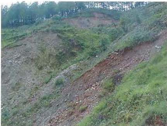
写真1 ダハチョーク上流部の状況
