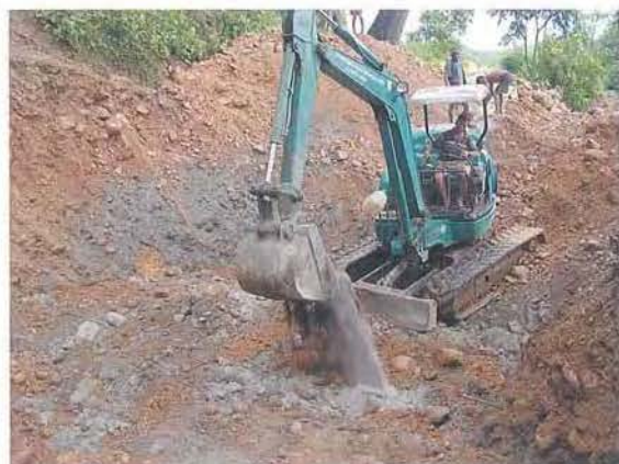
写真6 ソイルセメントによる地盤改良状況
