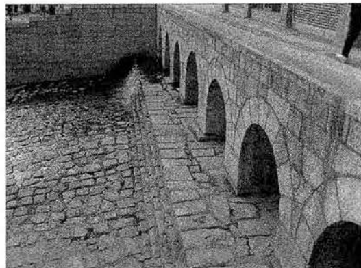
写真9-2 落差工部の石積み
