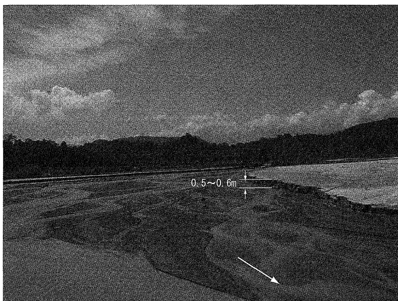
写真3 ビリビリダム上流にある砂防施設のうち、下流から数えて2番目の砂防施設（SP2）上流の土砂堆積状況
