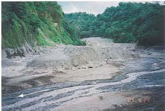
写真5 新設砂防えん堤の建設候補地点（崩壊土砂の堆積末端）
