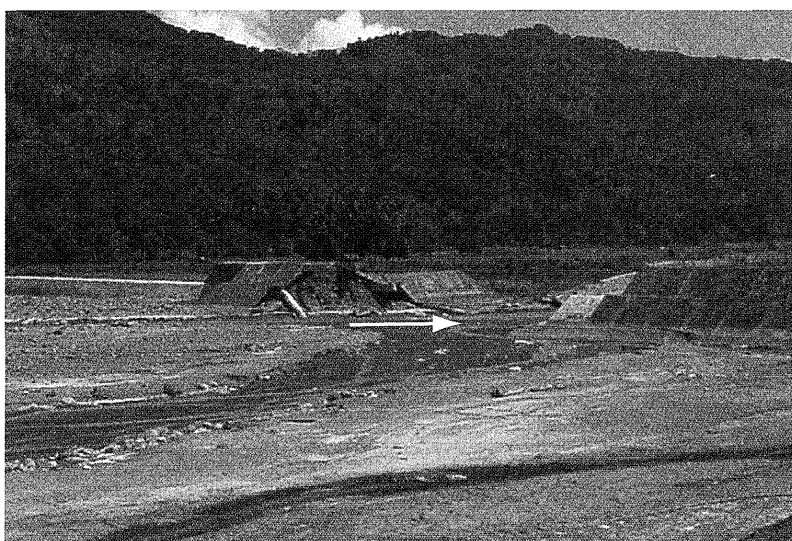
写真4 洪水によって破損している砂防施設（今回の巨大崩壊以前に破損していたもの）
