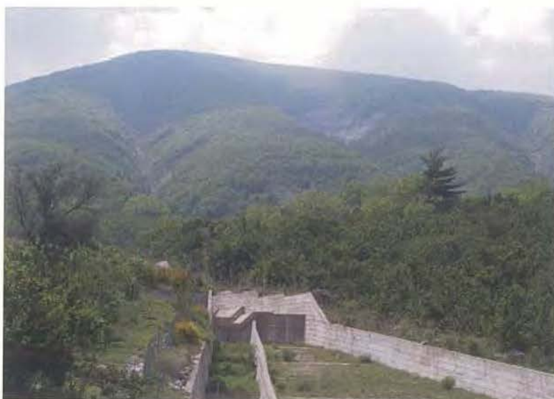
写真4 クインディッチの土石流発生溪流と遊砂地
