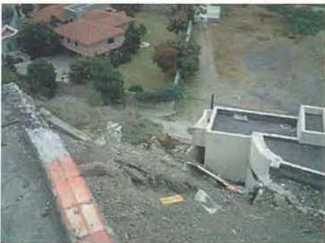
写真5 宅地開発状況とのり面崩壊（セロ・デラ・コロナ地区）
