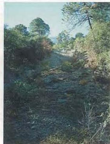
写真7 マリボサス溪谷地区道路盛土斜面崩壊
