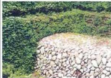
大崖砂防堰堤の石積み堰体
