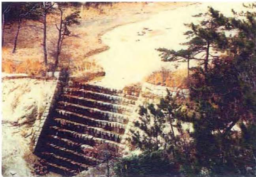
写真1-1 鎧堰堤（昭和56年撮影）
