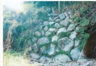
群馬県八幡川堰堤
