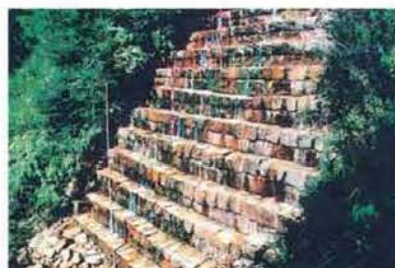
写真3-3 鍔堰堤（石積みの姿がよくわかる）
