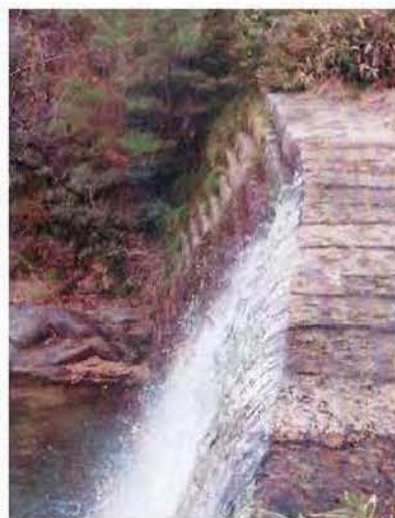
写真3-2 オランダ堰堤（上から）
