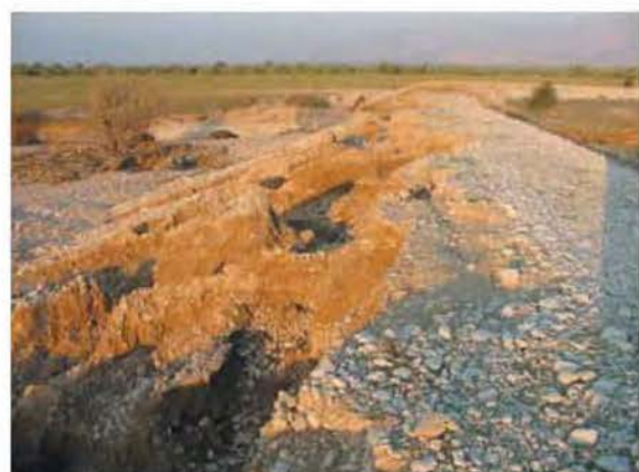
写真10 地下水涵養と洪水ピークカットをねらった土ダム (高さ5m) ● 出水時の越流で破壊された後の写真である (左岸袖より撮影。イラン南部ブッシュェール州)
