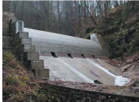
写真6 担当技術者の英知の限りをつくした砂防えん堤 ● 土砂が多いところには適さない設計だが…… (イラン北部マザンダラン州)
