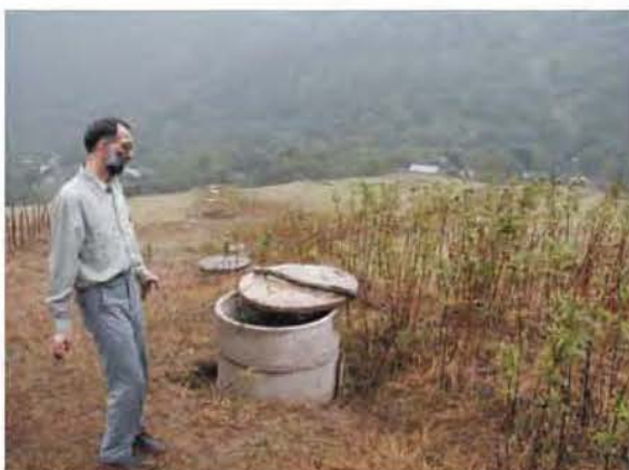
写真4 地すべり対策工（地下水排水工）（イラン北西部ギラン州）
