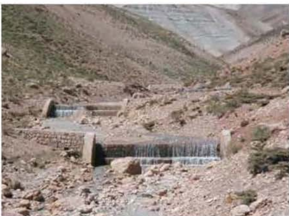
写真3 侵食防止のためのえん堤の建設は最も主な事業（イラン中部チャハルマハル&バクテヤリ州）
