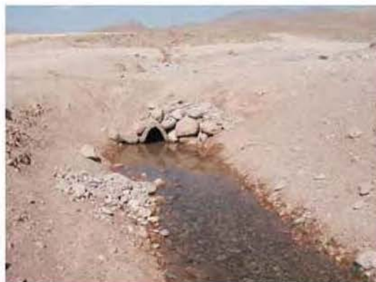
写真12 カナートの出口 ●数km先にある母井戸からほぼ水平に横穴を掘り、導水している（イラン中部ファールス州）
