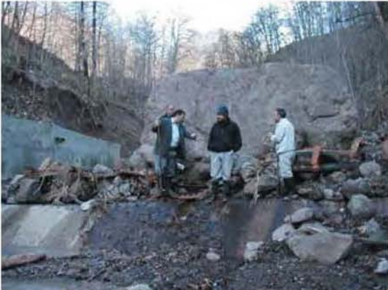
写真5 土石流に破壊されたスリット型砂防えん堤 ● この巨石は今回の土石流で運ばれた (イラン北部マザンダラン州)
