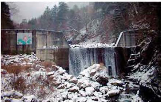
写真1 不透過型砂防えん堤
