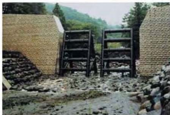
写真4 横材を機能部材とした鋼製透過型砂防えん堤の一例
