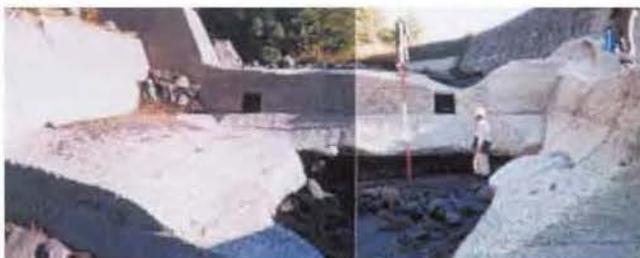
写真3-2 土石流により極度に摩耗した砂防えん堤
