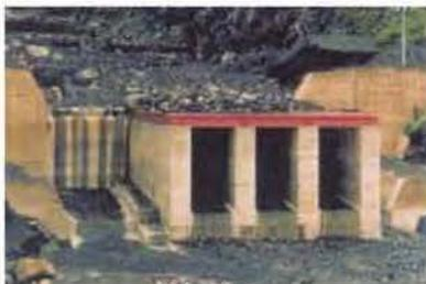
写真3-3 野尻川4号底面水抜スクリーンえん堤
