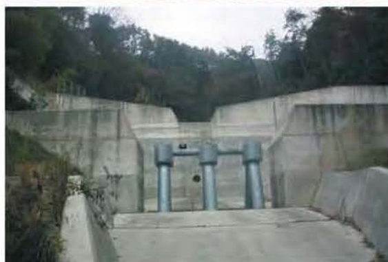
写真6 復旧事業により完成した砂防施設 上から安川左支川、屋代川、堂々原川（広島市佐伯区）
