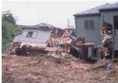
写真1 土石流による被害の状況 安川左支川（広島市安佐南区）死者1名、全壊2棟
