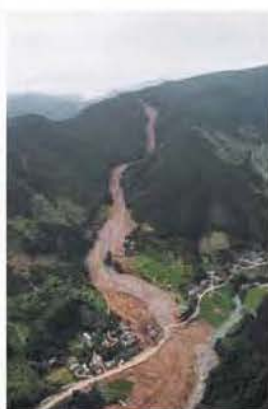
集地区災害現場（上空から）
