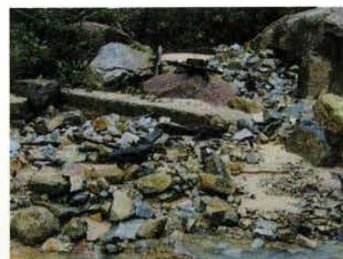
写真4 3つ目のCheck Dam
