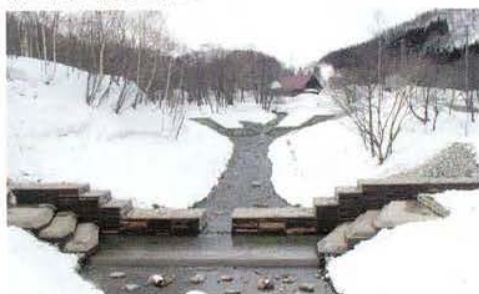
完成後の状況
