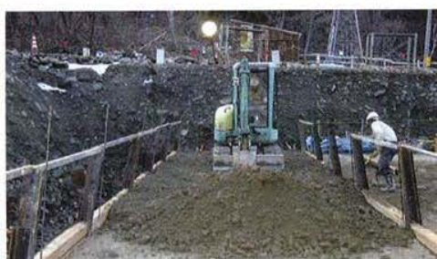
施工状況(敷均し作業)
