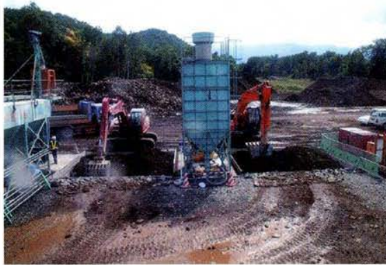
セメントとの攪拌・混合状況
