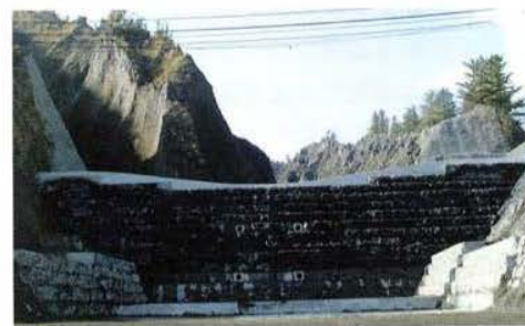
完成後の状況
