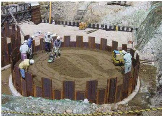
施工状況（締固め作業）
