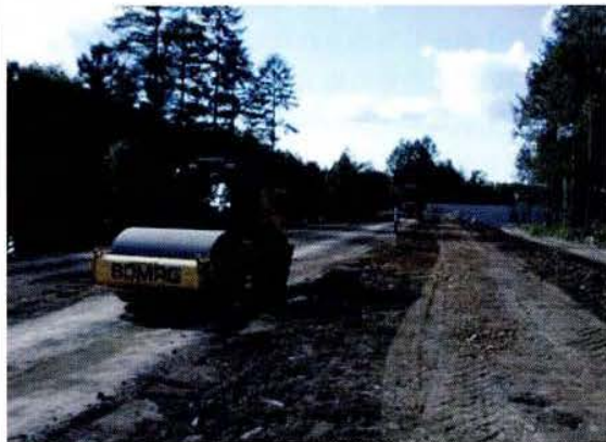
振動ローラによる締め固め状況
