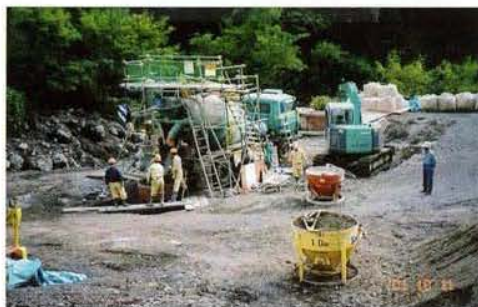
アジテータ車による混合
