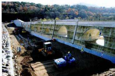
荒川遊砂地砂防えん堤における水叩きのINSEM施工状況(現地見学)
