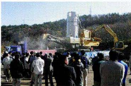
自走式土質改良機による現地発生土砂とセメントの混合状況(現地見学)
