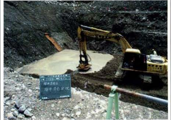
施工(ツインヘッダによる攪拌)状況
