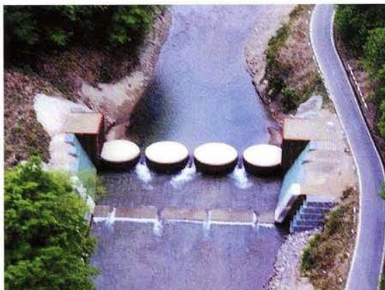
完成後の状況
