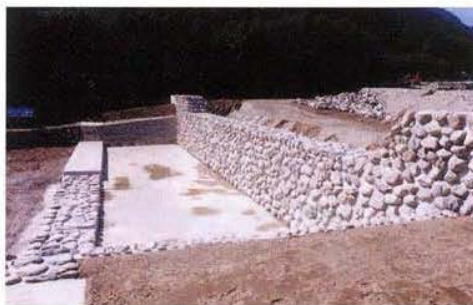
完成後の状況
