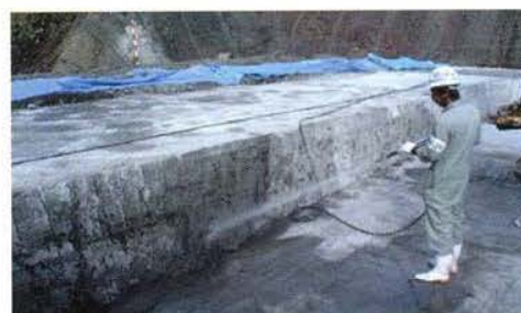
施工状況(鉛直打維面洗浄)
