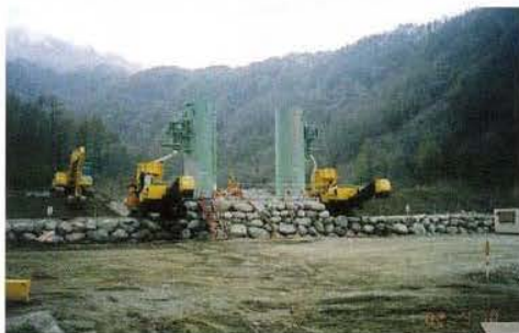
自走式土質改良機による混合
