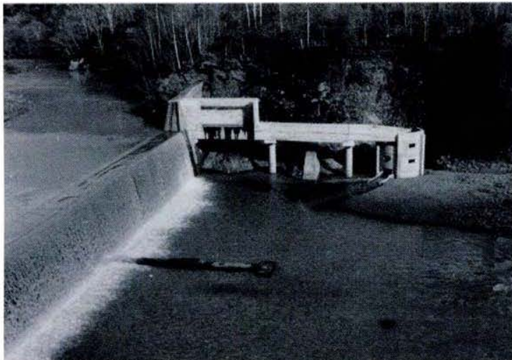
写真1 らせん型魚道。砂防えん堤の袖より緩勾配の水路が下流へ伸び、タワー状の構造物へと続く。タワーの内部は水路がらせん状に配置されている。
