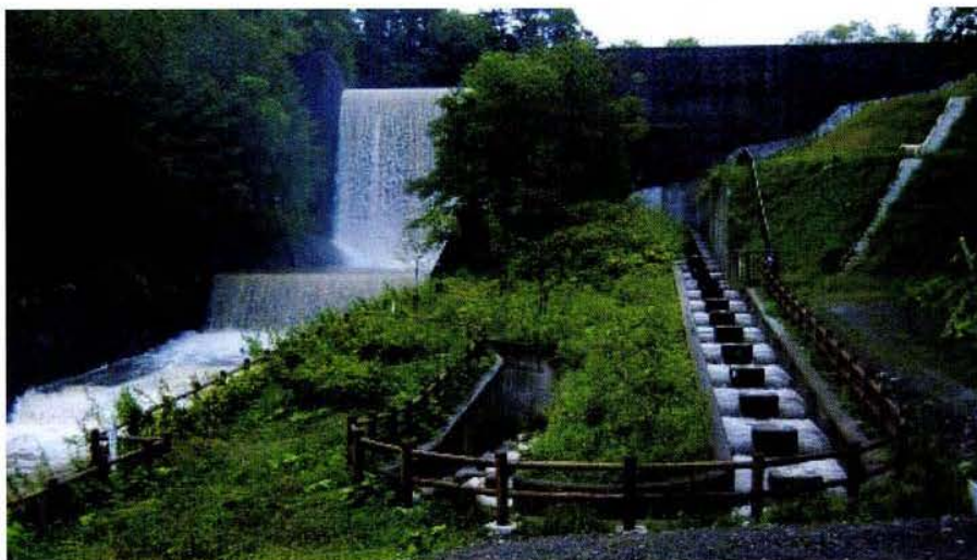
写真6 大型砂防えん堤と魚道（ベレケ川、北海道斜里町）。えん堤は堤高20mで、1970年竣工。魚道は2001年設置。
