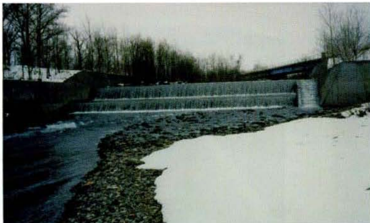
写真2 床固工と魚道。
