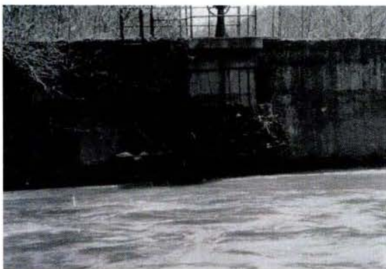
写真4 魚道出口（出水口）部分のゴミによる埋堰。
