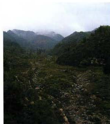
砂防えん堤より上流を望む
