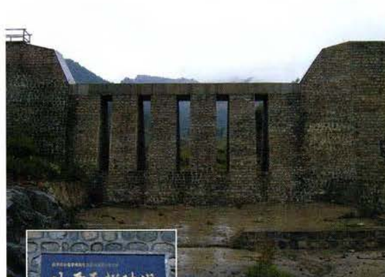
砂防えん堤正面
