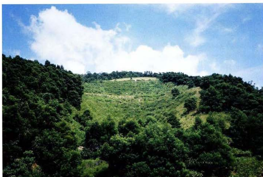
針原川崩壊跡地
