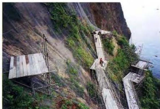
写真3 斜面上に設置中の仮設足場
