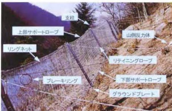
写真1 リングネット落石吸収柵の部材構成
