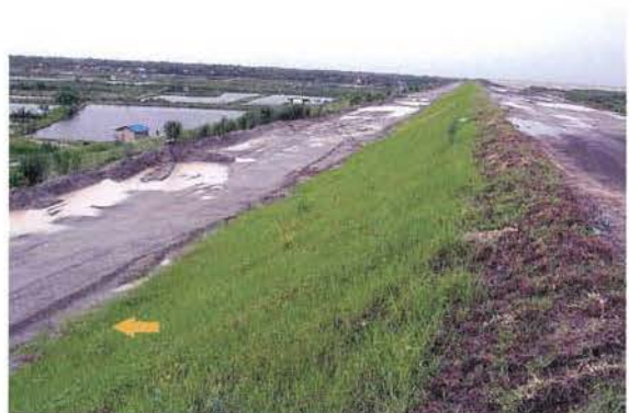
写真29 堤防嵩上げの状況 (h=5m)
