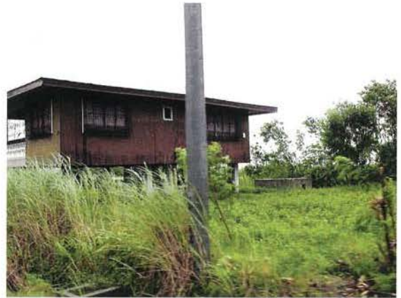
写真35 高床式で復旧された民家
