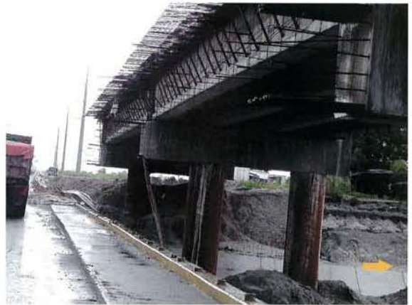
写真31 BARBARA BRIDGEの改修状況
