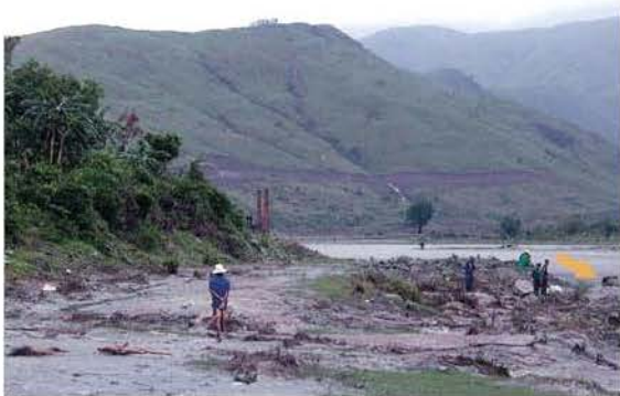
写真3 建設中のバイパス道路（フカオ川左岸）
