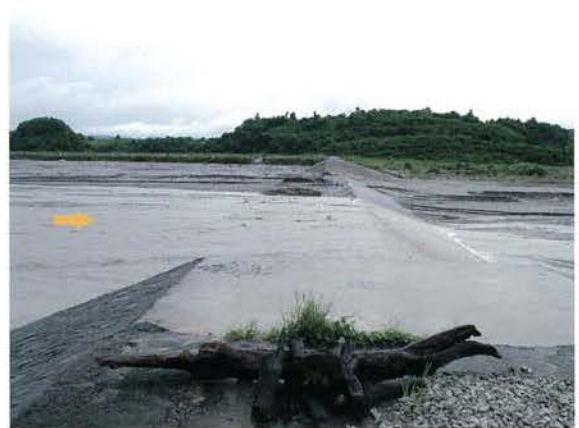
写真23 砂防ダム全景
