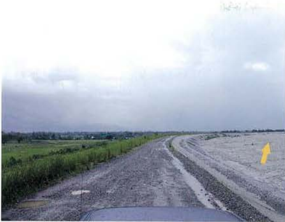
写真9 天井川となっているサントトーマス川
