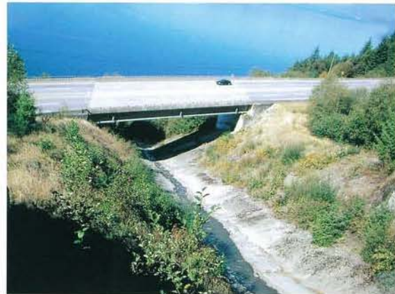
写真-3 Newman Creekの導流工（流路工）。扇状地左岸側にあった流路を右岸側に新たに付け替えてコンクリートライニングを施した。新しい流路沿いには人家がない。
