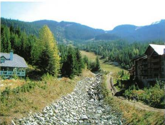
写真-8 Whistler Creekの下流流路部から上流部を望む。流域はスキーマのリゾート地として有名である。巨石を用いて環境・景観との調和をはかっている。
