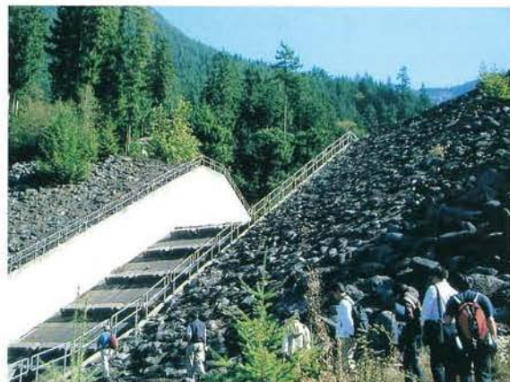
写真-4 Harvey Creekの土石流捕捉施設（遊砂地+透過部（RC製））の下流側。透過部の高さは15mである。Charles Creekと同様の設計となっている。
