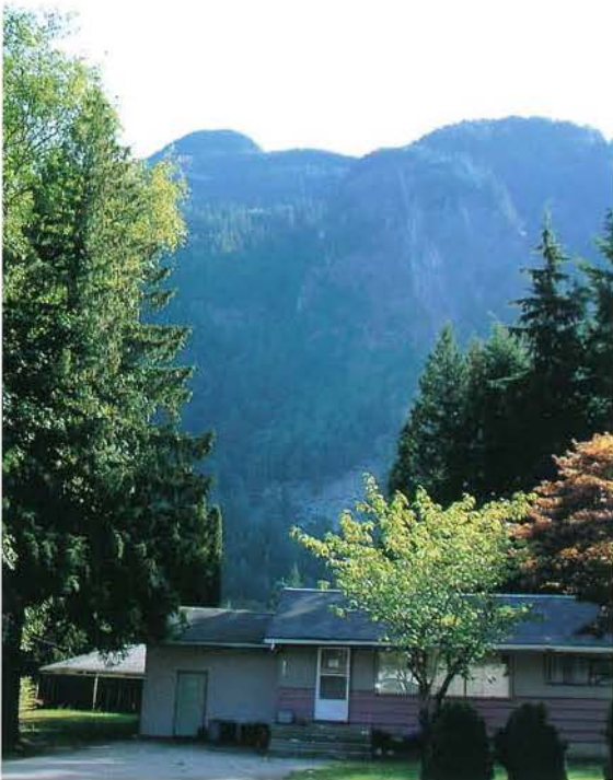
写真-13 Silverhope 地区は落石の危険区域である。これまでも幾度か被害を受けている。
