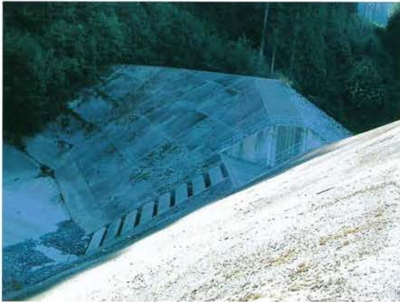
写真-2 Charles Creekの土石流捕捉施設（遊砂地+透過部（RC製））。透過部の高さは15mである。初期の設計であるため、かなり安全側に作られていると説明された。袖部上流側はコンクリートでライニングされている。
