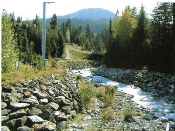
写真-10 Fitzsimmons Creekの下流流路。1991年8月の災害後に改修された。スキーリゾート地で有名なWhistlerの中心部を流れる渓流である。
