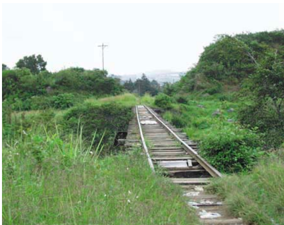
写真-1 レベント川にかかる鉄道橋と右手にみえるのが土堤
