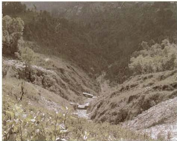
写真6 地すべり地下部における石積み堰堤
