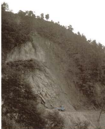
写真7 国道の岩盤すべり
