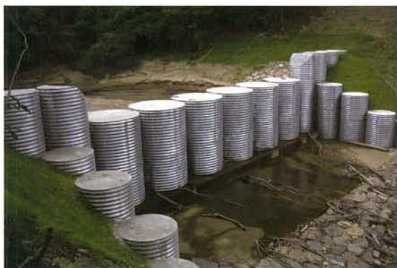
写真7 芝岩コルゲートセル堰堤全景
