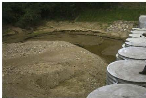
写真9 芝岩コルゲートセル堰堤上流の堆砂肩
