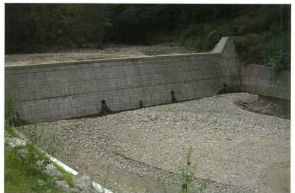
写真5 芝岩コンクリート堰堤（本堤 化粧型枠）
