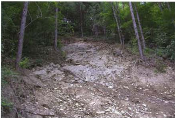
写真3 崩壊地の状況
