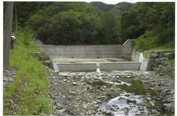
写真4 芝岩コンクリート堰堤全景（副堤にスリット）
