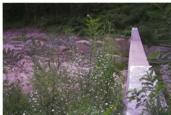
写真6 芝岩コンクリート堰堤側面（上流側が直）
